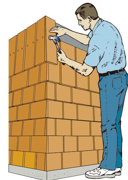
図9: 互い違いに納める出隅の施工
