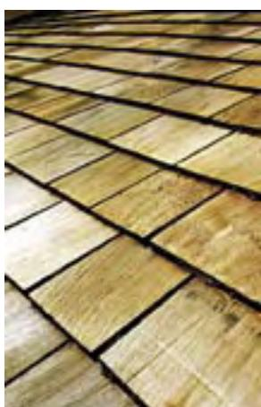
屋根材のシングル・シェイクは日光の強い紫外線(UV)に晒され、ゆっくりと腐食していきます(Swan et al. 1988)。BC州ヘイニーにあるブリティッシュ・コロンビア大学実験場で行ったシェイクを南向きの日光に晒した暴露実験では、8年間で約
