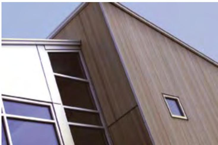
能を示します。振動を吸収し、騒音を閉じ込める特性を持つため、パネル材としてその長所を発揮します。あらゆる建築様式にぴったり融け込み、住宅、商業建築や工業用建築物など幅広い用途に利用される汎用性を擁しています。また、サウナ浴室によくシダー材が使用されるのはその低熱伝導率の特性によるものです。
